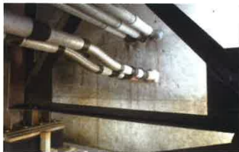
橋梁部の耐震対策
