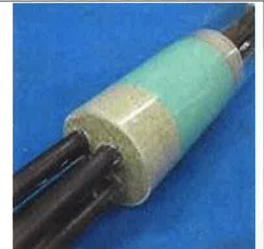
管路内の止水状況
