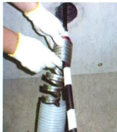
ハンドホール内から既設管路の耐震対策
