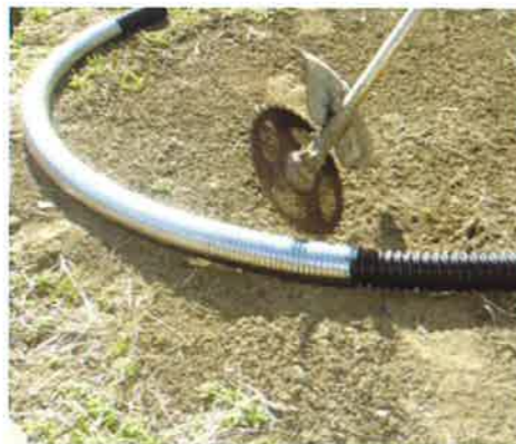
樹脂管路の草刈対策
