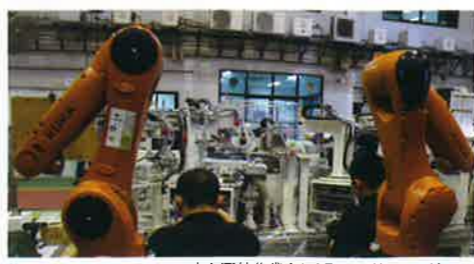
丁寧な配線作業を行うEureka社のエンジニア
