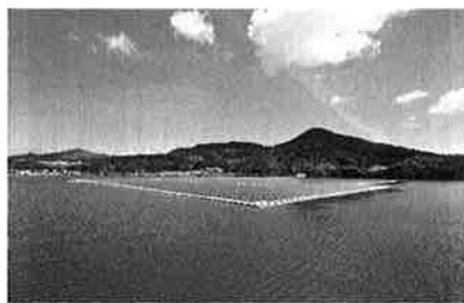
写真7 ため池ソーラー発電設備
